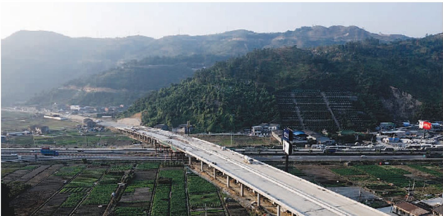
瑞枫公路第二标段西岙高架桥施工进入防撞护栏和桥面铺装等扫尾阶段。据了解,投资2407万元的西岙高架桥全长404.33米,于今年1月开工,将于年底完工。该高架桥与高速公路形成立体交错,预计12月底将拆除大桥施工平台,确保瑞枫公路通车。
