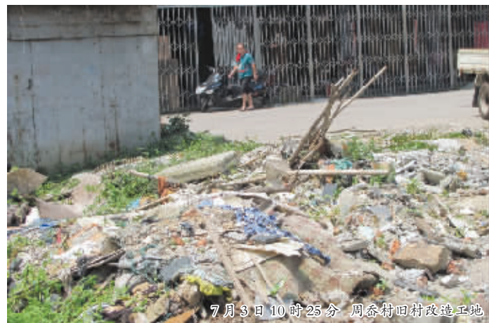
7月3日10时25分 周岙村旧村改造工地
