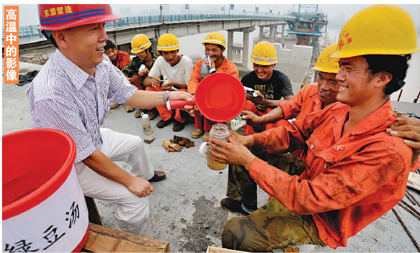
日前,飞云江大桥改建工程施工单位专门熬制了绿豆汤,准备了藿香正气水清凉油等药物,为施工人员送去清凉。同时,实行提前上午工作时间,延长晚上工作时间,避开中午最热的时段,避免施工人员在烈日下的时间过长。(记者 孙凇)
