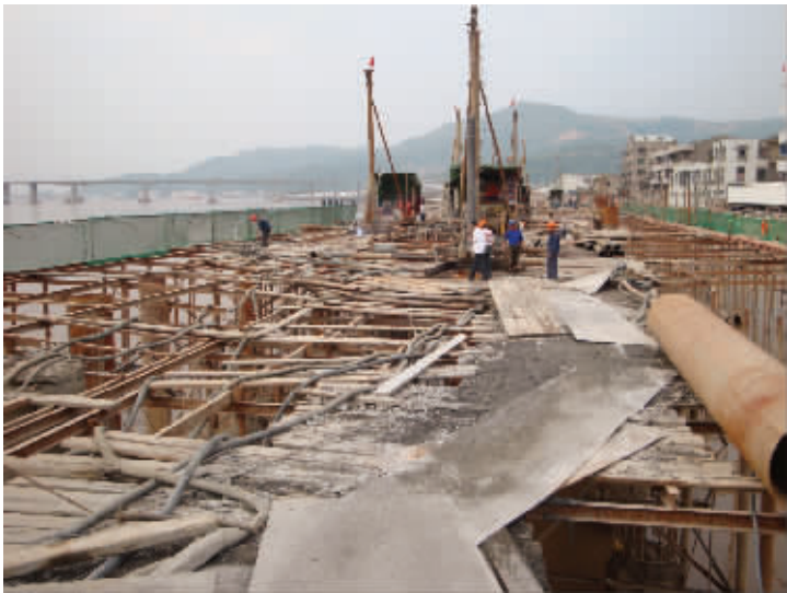
瑞安市城市防洪三期工程施工现场
