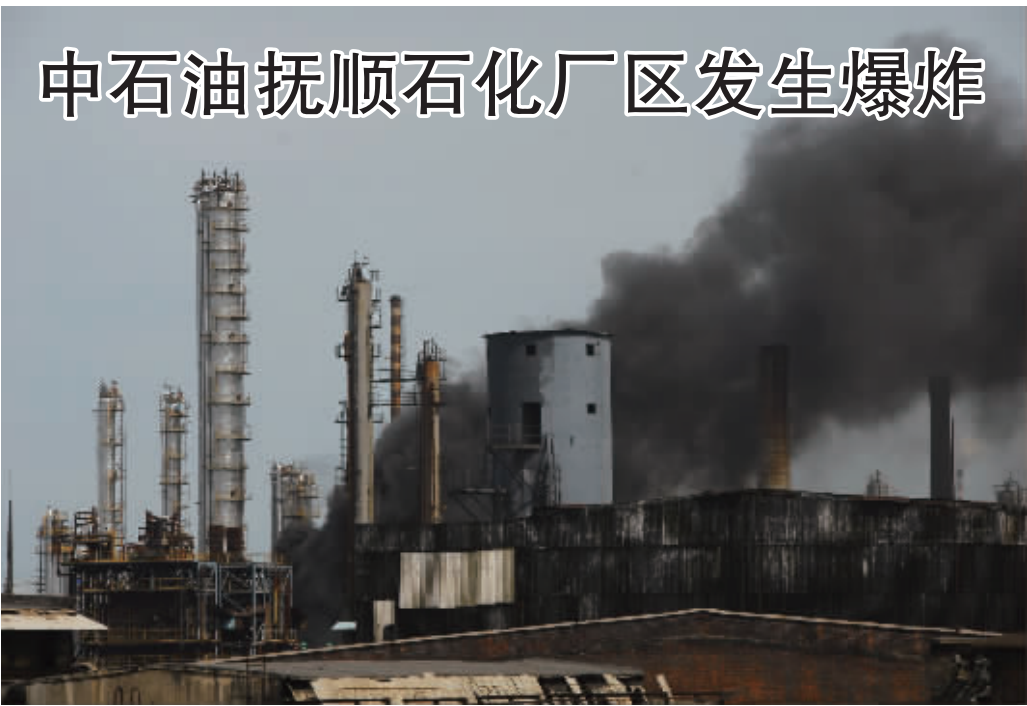
这是发生爆炸后的中石油抚顺石化厂区(9月7日摄)。 9月7日中午,中石油抚顺石化厂区发生爆炸,目前没有造成人员伤亡。(据新华社)
