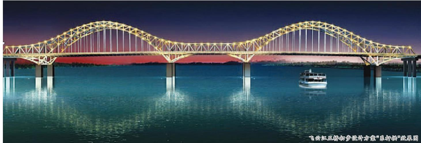
飞云江五桥初步设计方案“系杆拱”效果图
