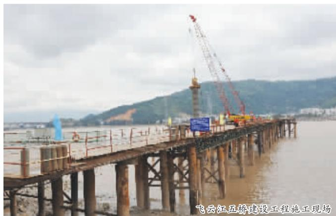
飞云江五桥建设工程是省重点建设项目，南接瑞安火车站前江南大道，北至瑞枫公路，全长2.8公里。其中大桥全长1.02公里，宽32.5米，主桥桥型为五孔中承式钢桁架系杆拱桥，设计行车速度每小时50公里，项目总投资约9.39亿元，工期3年，力争提前半年完工。
