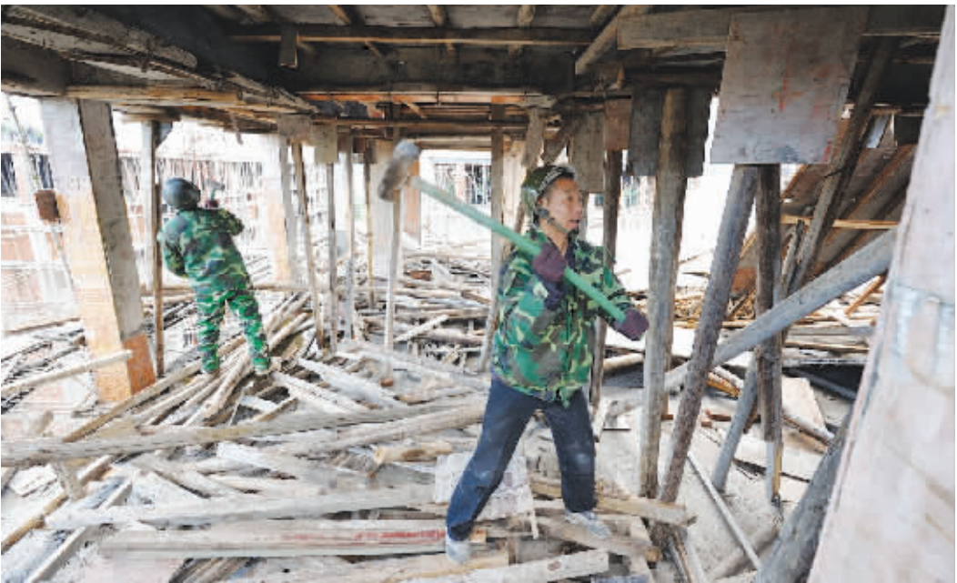
日前，锦湖街道办事处联合规划、公安等部门，开展“两违”整治行动。执法人员组织300多名拆违公司员工，调来空压机等设备依法拆除违章建筑。经过一天的行动，联合执法组共拆除违章面积3600多平方米。（记者 孙漂）
