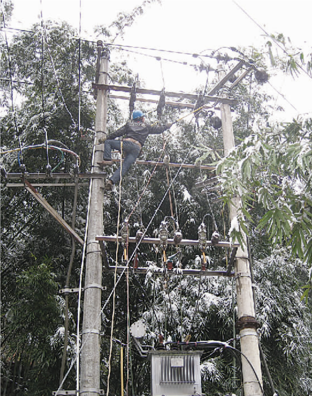
电力人员冒雪抢修线路
