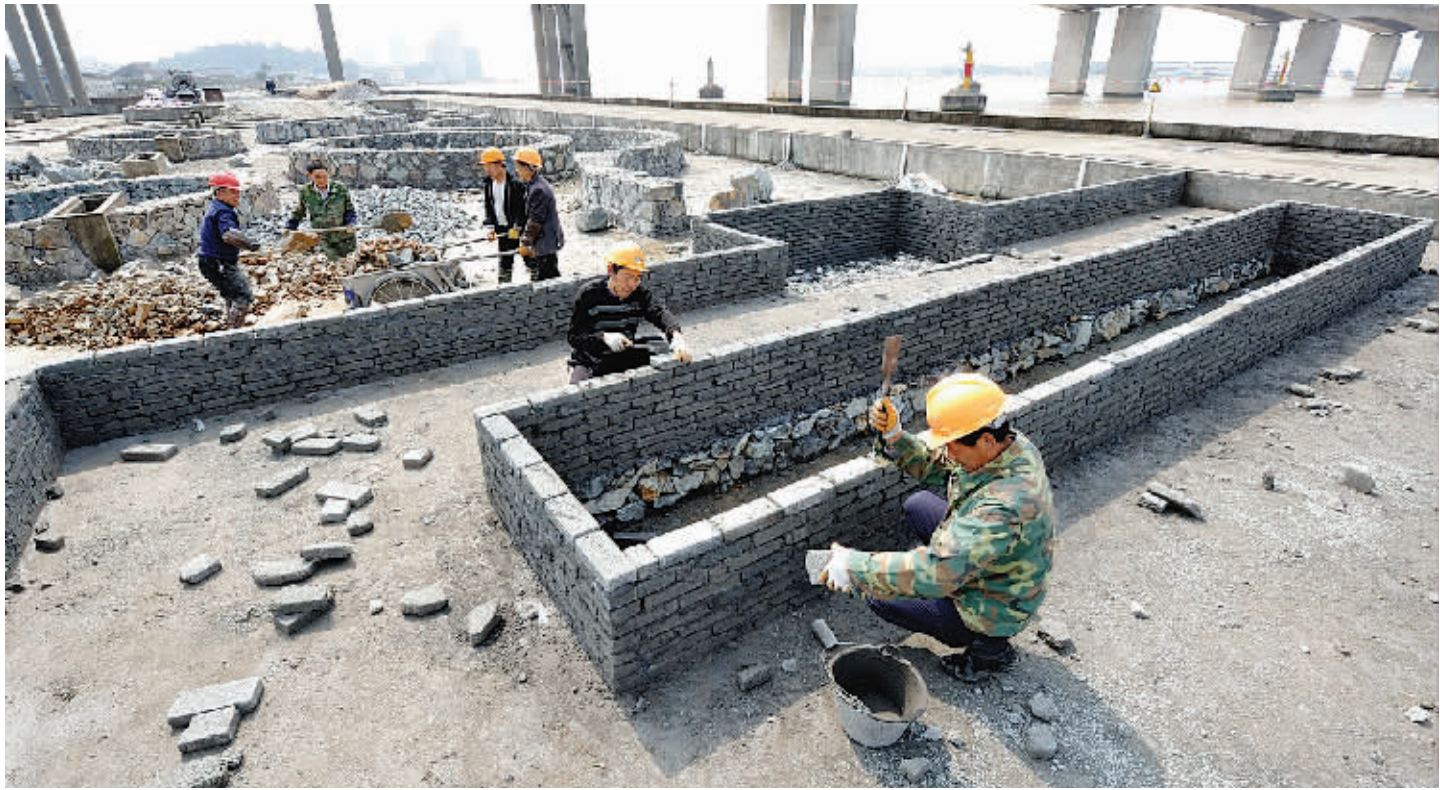
3月21日,在市防洪三期环境景观建设工程施工现场,施工人员正忙着修建花坛。该工程是市北岸防洪闭合区工程的重要组成部分,总投资5493万元,全长约1945米,从安阳街道小横山至南门口,与滨江二期防洪堤工程连接,预计于2013年6月份完工。据了解,该工程今年投资1600万元,现已进入花坛、水池造型施工阶段。(记者 孙凇)
