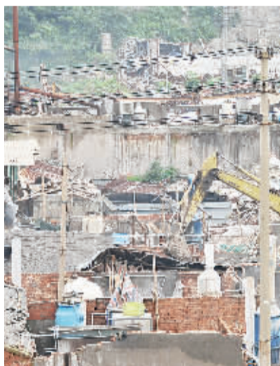
霞林村拆违现场 杨微微/摄
