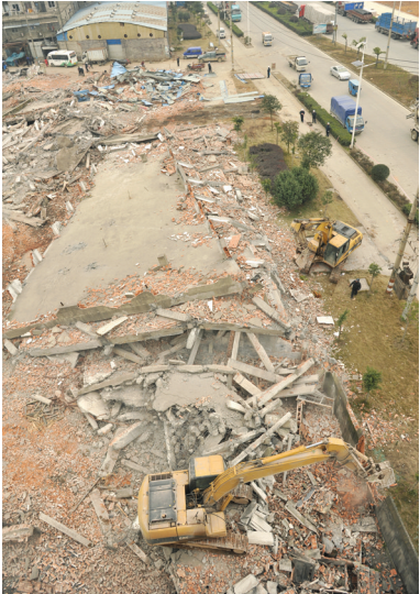
罗山大道道路旁拆违
