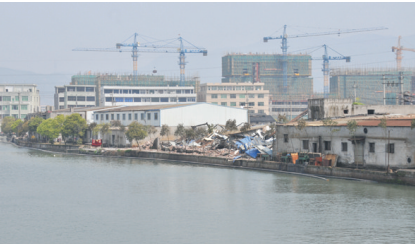
温瑞塘河陈宅村段拆违现场
