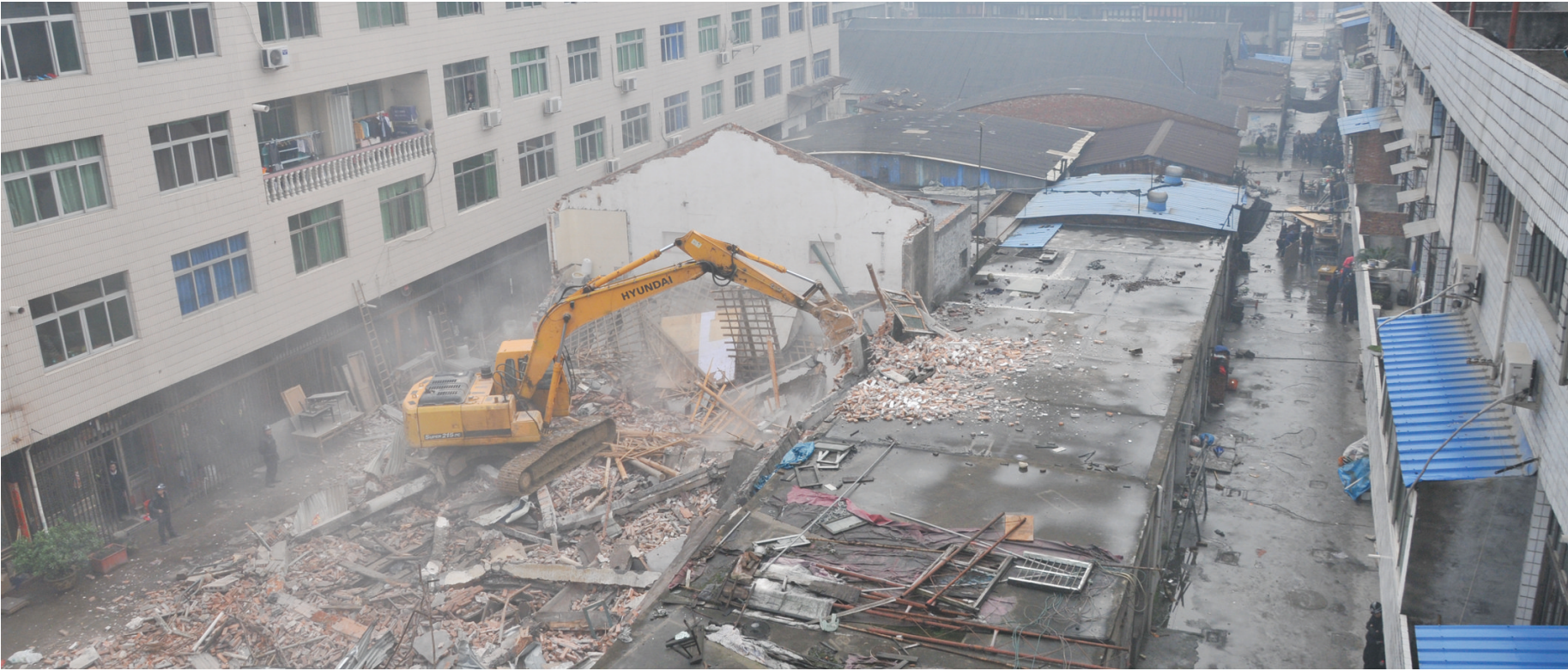
官进村拆违现场
