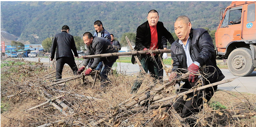
图为安阳街道千群在拆除瑞枫公路沿线的违章棚架
