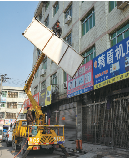
拆除三楼以上广告牌
