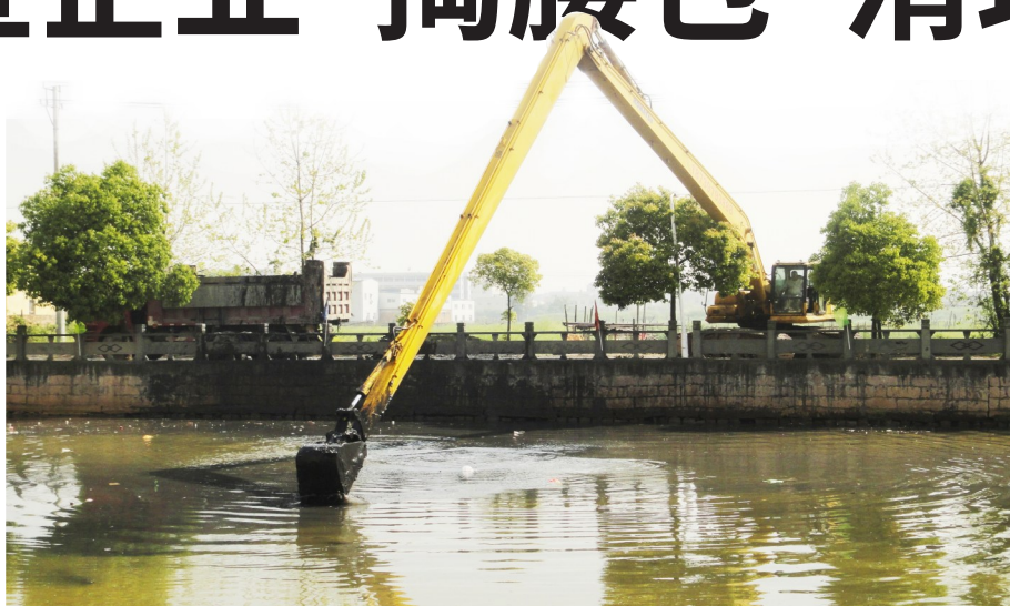
挖泥机清理河道淤泥
