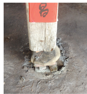
石柱础被盗后用石头、砖头托着柱子
