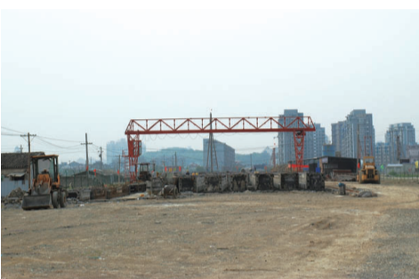
建设中的陈虬路
