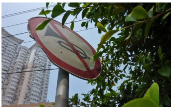
塘河北路高架桥下标志牌被撞歪
