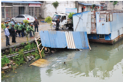
拆违人员在拆除船屋
