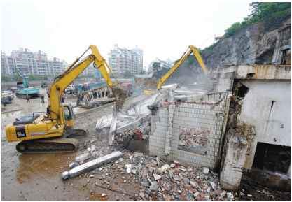
违章冷冻厂拆除现场
