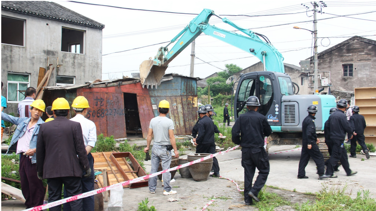
现场拆除违章建筑，执勤人员拉起警戒线。
