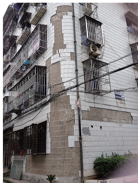
凤山小区31幢楼外墙瓷砖脱落严重,一大片灰色墙体裸露在外。
