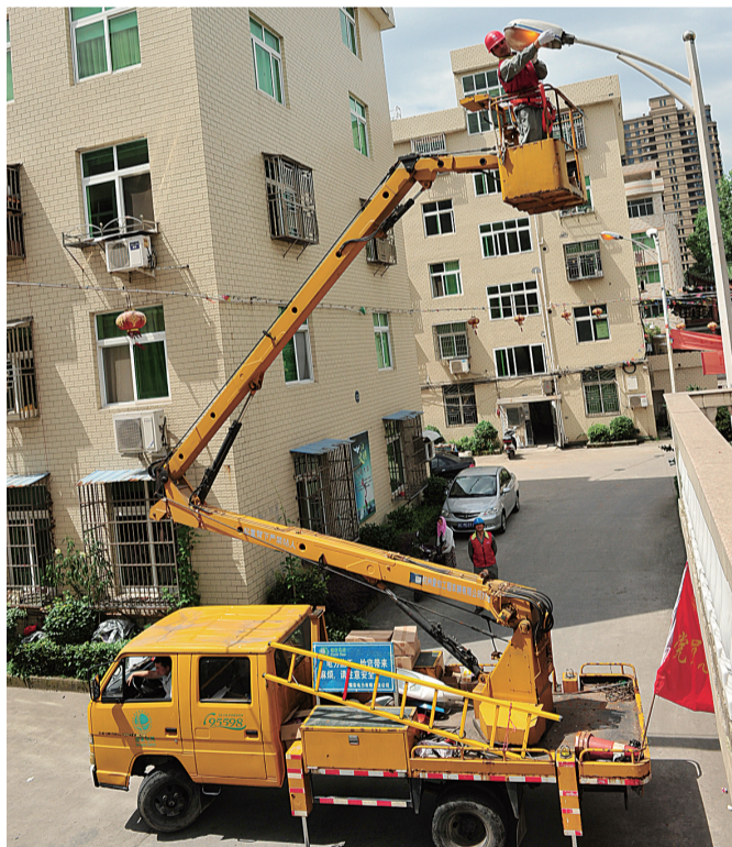
鲍田供电所党员志愿者在新坊村老人公寓修理路灯
