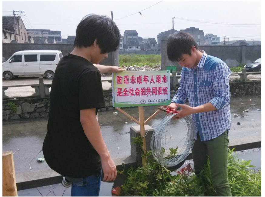
工作人员安装警示牌
