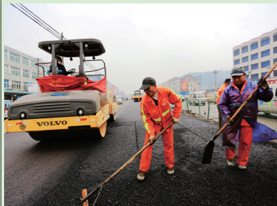
施工人员在路面铺设沥青
