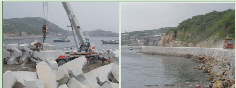
北麂一级渔港工程
