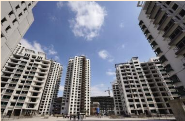
东山下埠现代化新农村试点工程结顶
