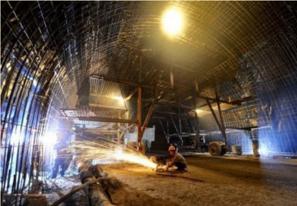
万松山隧道施工现场
