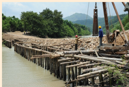
自行车绿道江心岛堰坝，工人在进行堰坝
