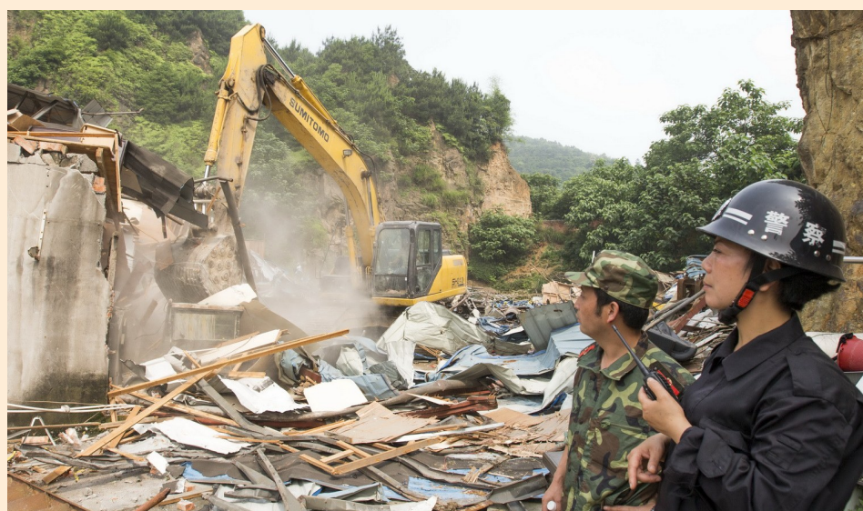
6月6日,安阳街道联合相关部门,对下沙塘村万松山脚下的50000平方米违章厂房进行拆除。
