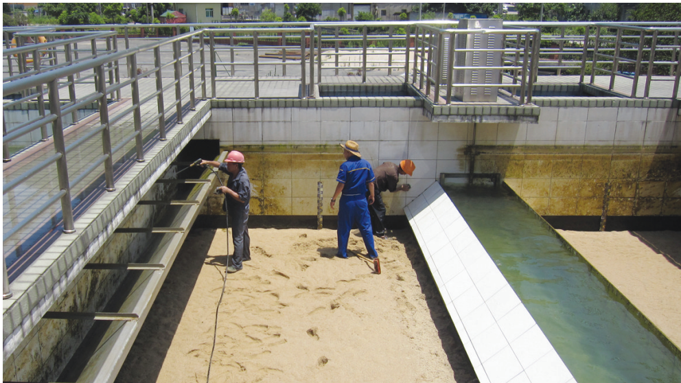
水厂工人在清洗滤池
