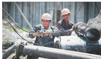
桩基工程 陈立波 摄
