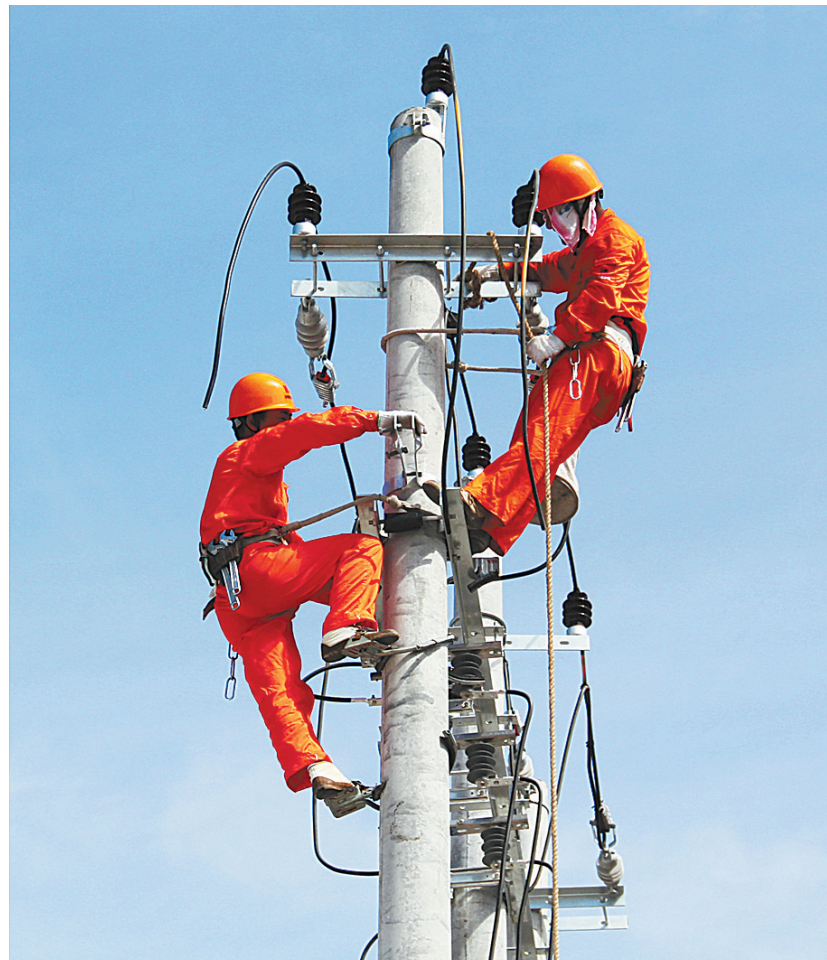
高空作业 曹建光 摄
