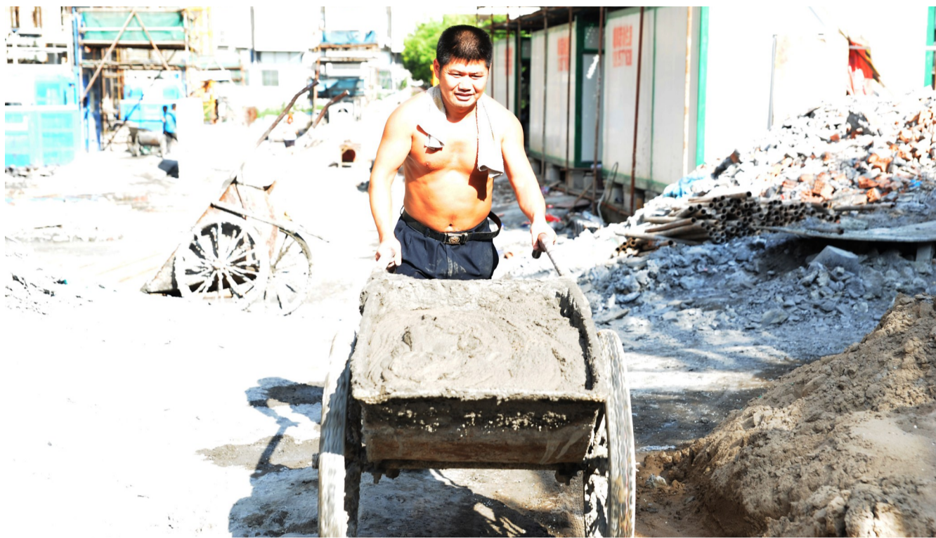
白岩桥村一工地现场，工人在烈日下干活。
