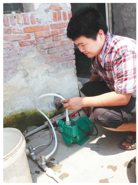
潘先生用刚买来的水泵抽水
