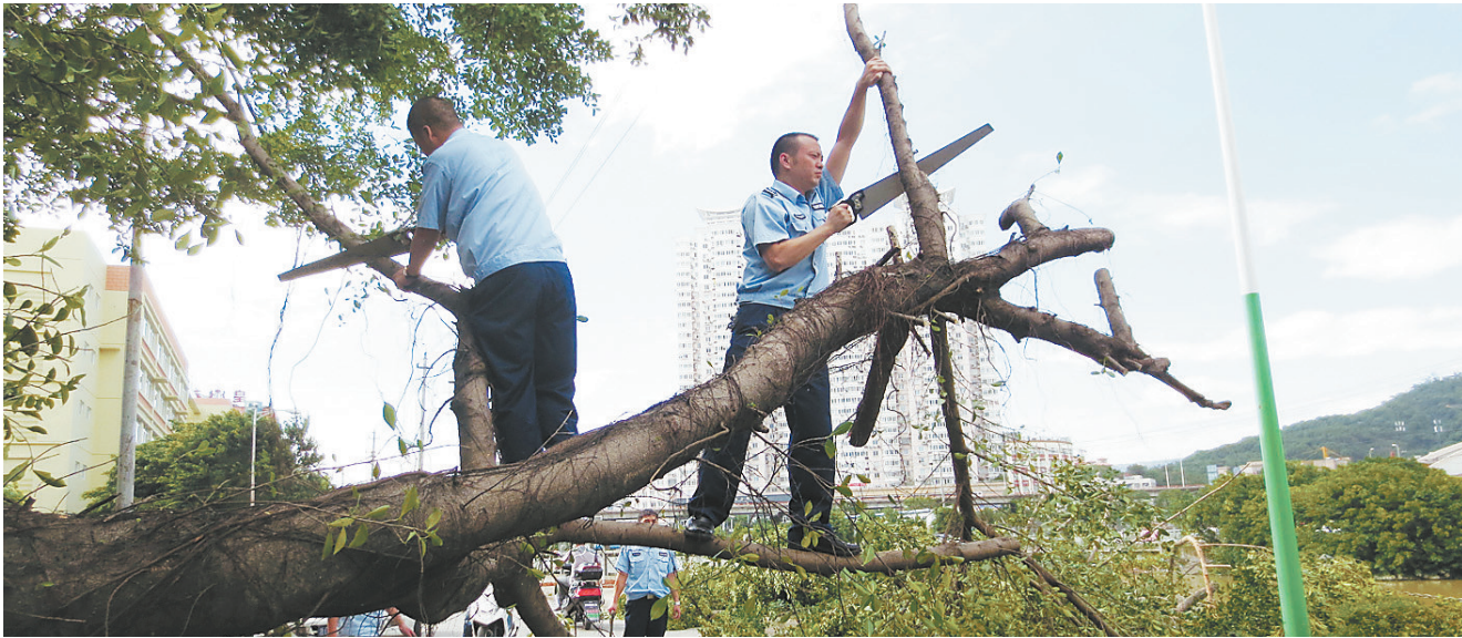
城建监察工作人员清理倒伏树木
