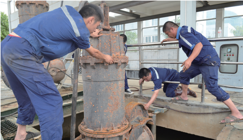
水务人员检修3号取水泵
