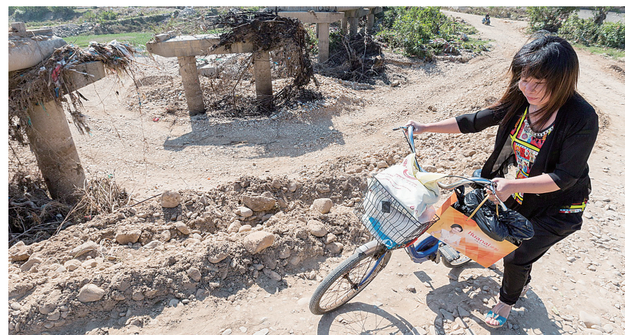
村民通过斜坡通行
