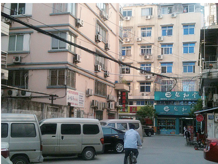
后垵住宅区电线架设杂乱
