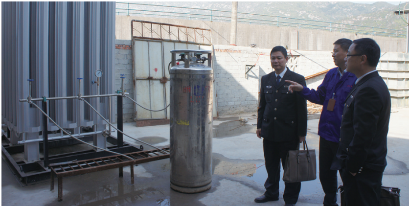
温州盛中石化装备有限公司技改现场
