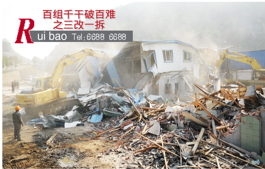
锦湖街道拆违现场
