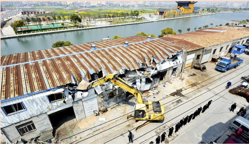
塘下镇溪塘塘河沿岸拆违现场
