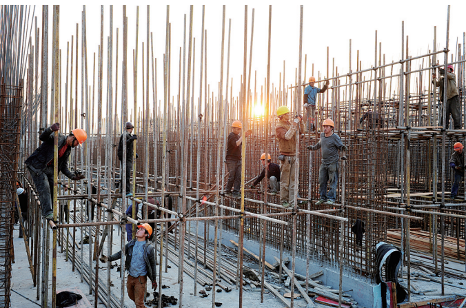
大年初三,工人在搭建生化池主体的脚手架。
