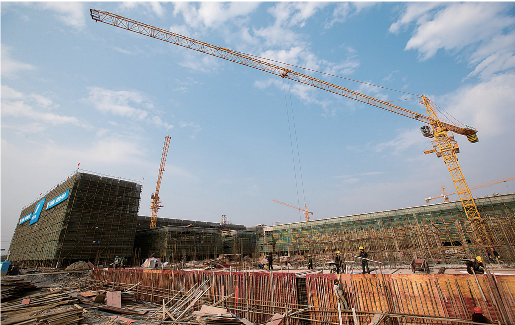
五洲国际商贸城紧张施工中
