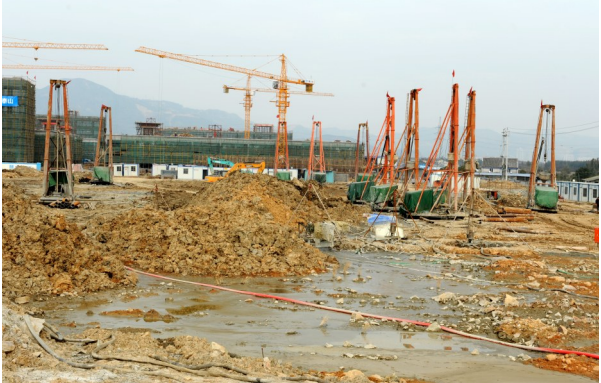
五洲国际商贸城二期施工现场
