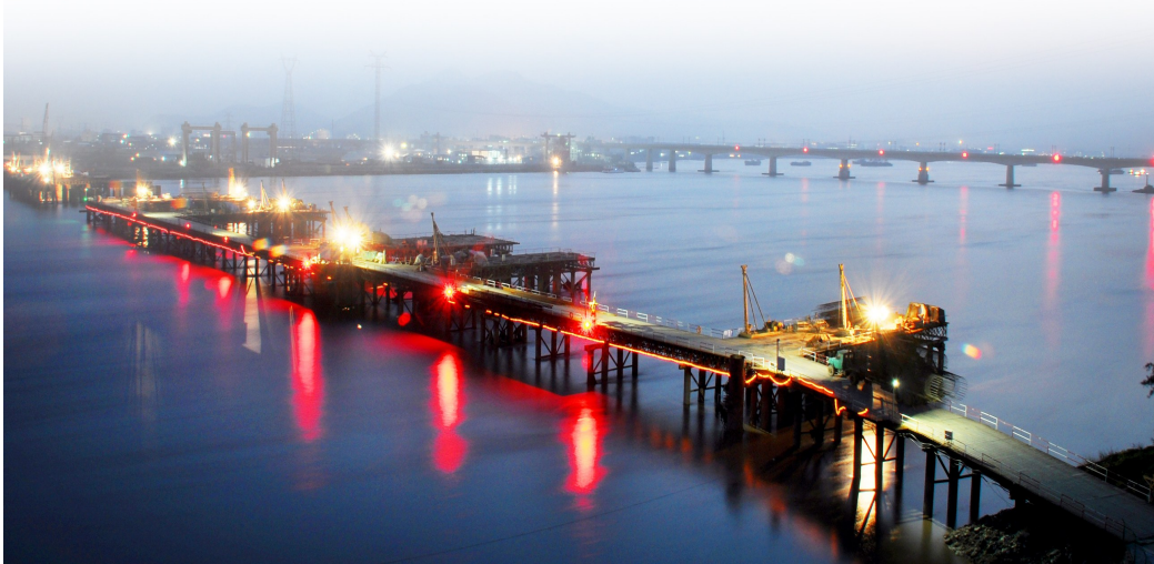
建设中的飞云江五桥
