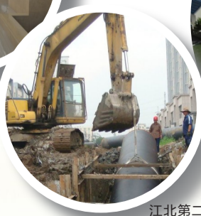
江北第二条出厂管厂前路段施工
