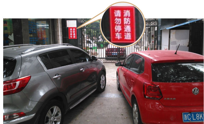
万松花园西面的一个侧面,消防通道被小汽车堵了。
