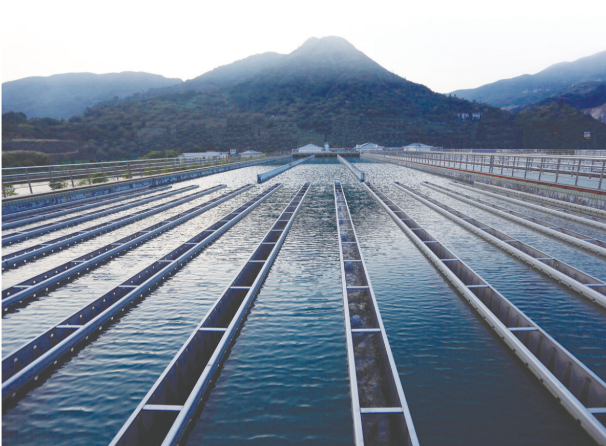
凤山水厂沉淀池
