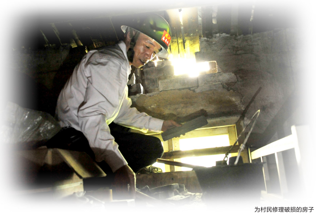
为村民修理破损的房子
