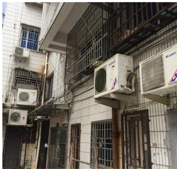
部分空调支架锈蚀,连固定螺丝也已松动
