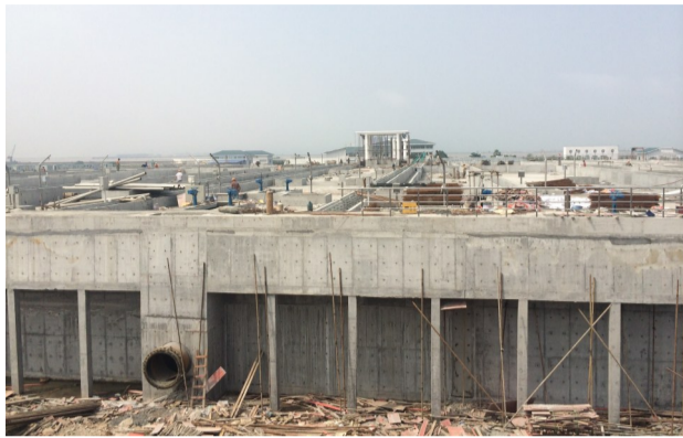
江北污水处理二期工程施工现场
