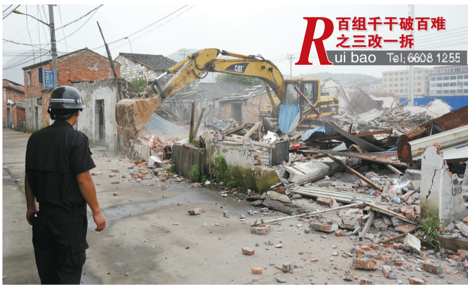
韩田村拆违现场
