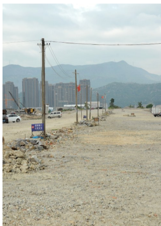
建设中的瑞安大道
